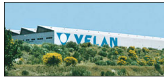
Lisbon, Portugal Velan Válvulas Industriais, Lda.
